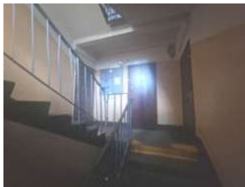
1.stāva kāpņu telpa
